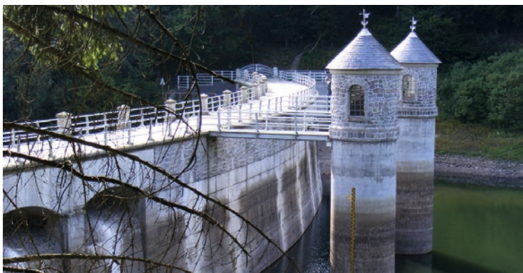
Die Talsperre Neustadt mit der ältesten Staumauer Thüringens.
